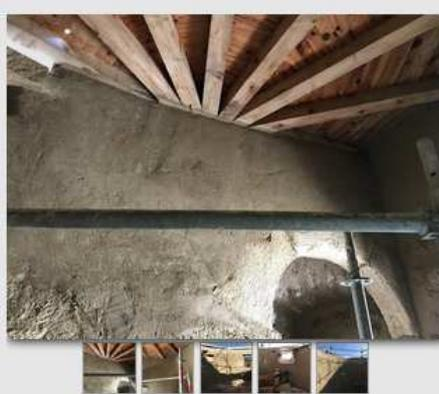
Les enduits intérieurs sont en cours de réalisation. Un brossage de finition devrait laisser apparaître les têtes des pierres. Le séchage permettra l'atténuation des contrastes.
