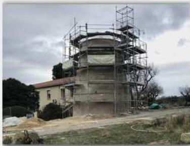
Après un gros travail de découfrage, purge et colmatage, la façade du moulin a reçu le corps de son nouvel enduit. On peut observer sur la corniche séparant la partie cylindrique de la partie tronconique, la mise en place des parefeuilles qui couvriront cet ouvrage périphérique.
