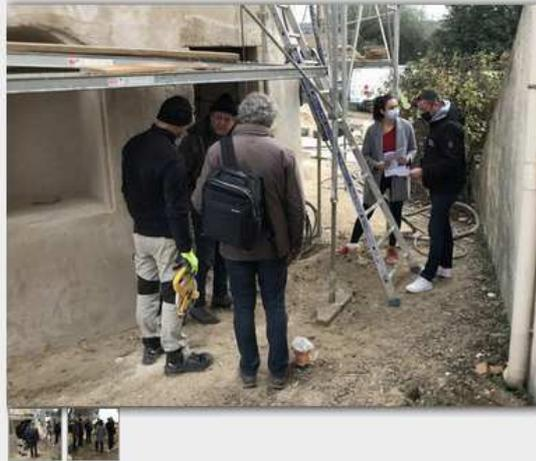
La validation du rendu final de la façade extérieure constitue une étape importante. L'avis des "bâtiments de France" avait été sollicité afin de garantir à l'ouvrage un fini se rapprochant au mieux de l'aspect originel du moulin. Le choix d'une projection à gros grains a été finalement retenu.
