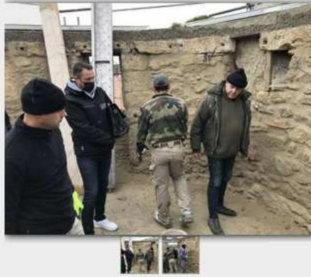
Inspection des enduits intérieurs avec Mr Cosme de la Fondation du patrimoine. Le mot d'ordre: beurrage "tête vue", c'est à dire noyant la pierre jusqu'à son niveau le plus saillant, même si cela doit la rendre moins visible... Il faut encore charger...
