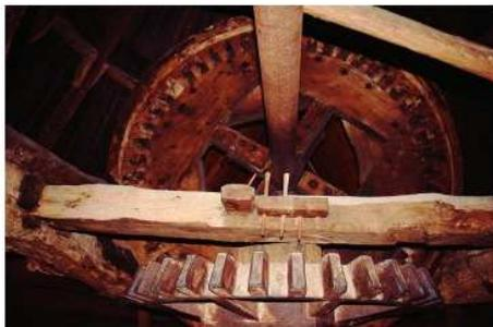
Restauré en 1962, il possède encore tout le mécanisme intérieur : grand rouet, gros fer et les deux chambres des meules. Ces meules, taillées dans le granit du Sidobre près de Castres, effectuaient un tour par seconde.
